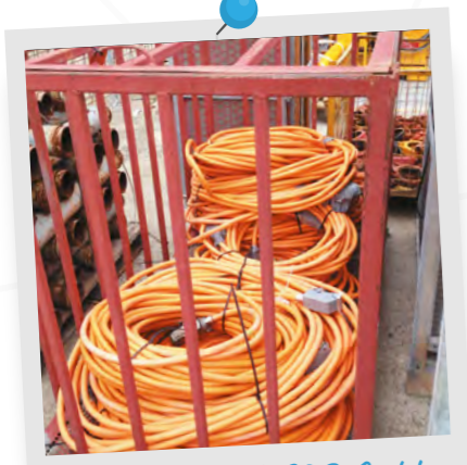
Steuerkabel / SPS Cables
